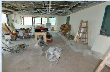
裝修工程進行中
